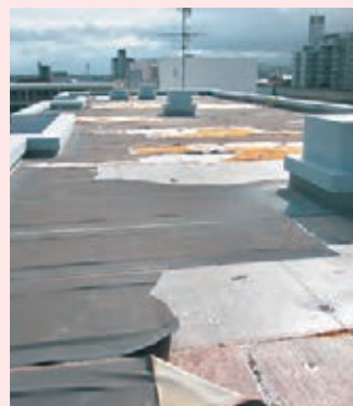
紀和駅団地8号棟の屋上
