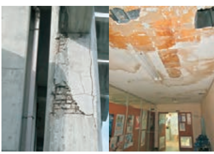
場・送水ポンプ棟 管理棟内部
