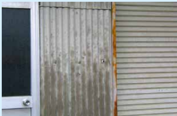
石綿スレート（屋根・外壁）
