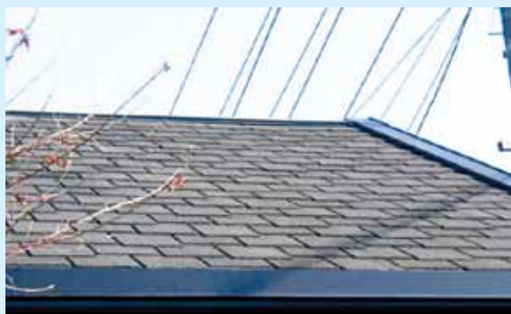
石綿含有住宅化粧用スレート（屋根）
