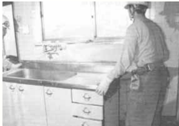
写真 流し台の撤去
