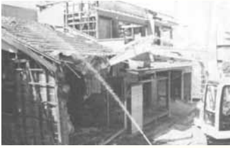
写真 桁側からの解体
