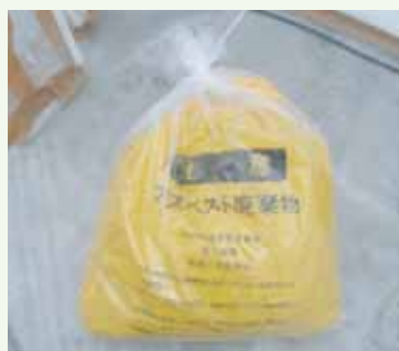
アスベスト廃棄物の二重袋詰
