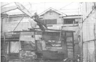
写真 1階桁側の解体
