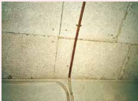
木毛セメント板（打ち込み）
