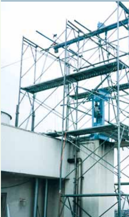
煙突上部及び灰出し口を隔離養生
