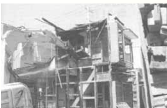
写真 2階妻側からの解体
