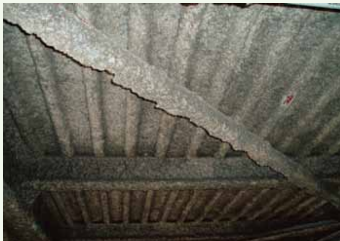
断熱用吹付け石綿・石綿含有吹付けロックウール（折版屋根裏、デッキプレート床裏、階段裏・庇裏等の断熱）
