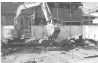
写真 基礎の解体
