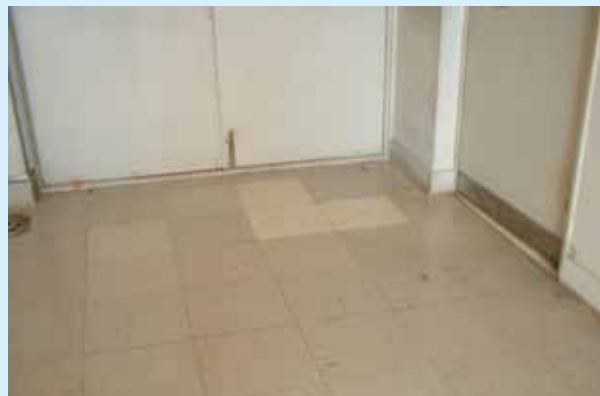
石綿含有ビニール床タイル（床）
