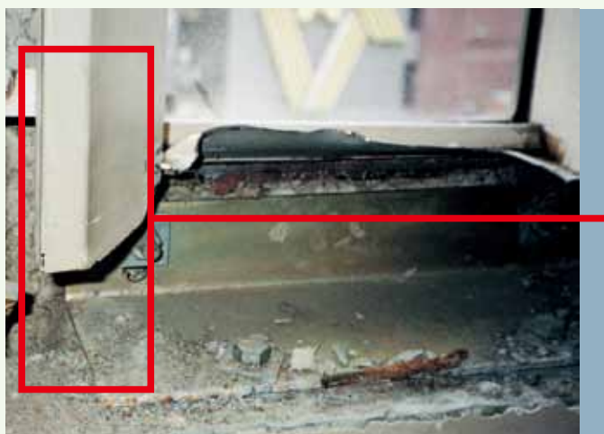
結露防止用吹付け石綿・石綿含有吹付けロックウール（カーテンウォール裏等の結露防止）
