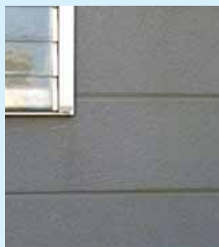
石綿板（窯業系サイディング）
