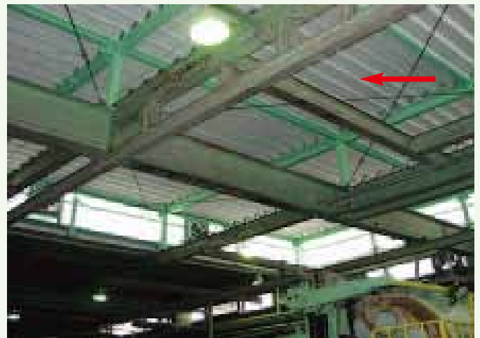
屋根用折版断熱材（折版屋根裏）
