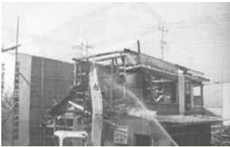
写真 2階妻側からの解体
