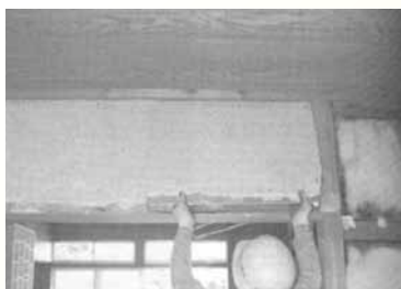
写真 石膏ボードの撤去
