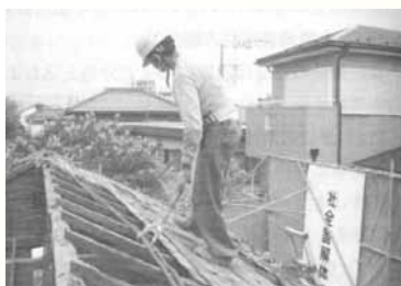
写真 屋根の解体
