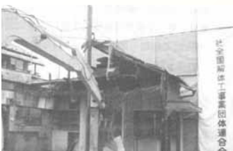
写真 1階妻側からの解体
