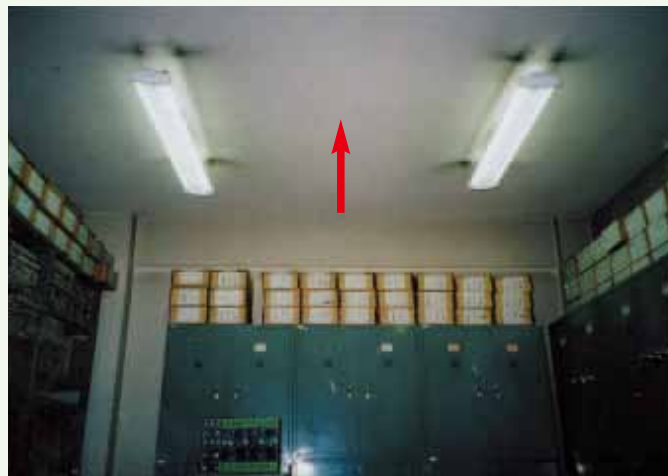
結露防止用の石綿含有パーミキュライト吹付け・パーライト吹付け（天井・壁等の結露防止）
