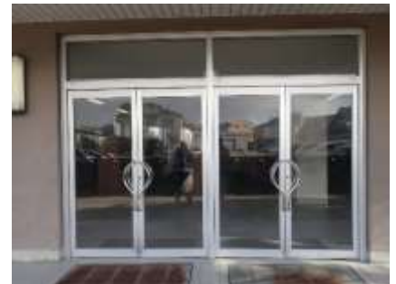
西校舎西側入口(中扉)
