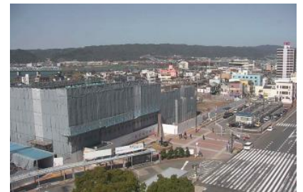
現在の和歌山市駅(解体中)
