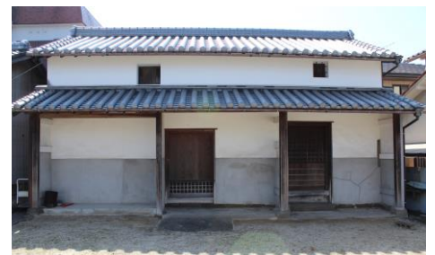
改修予定の古民家
