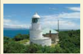
ともがしまとうだい 友ヶ島灯台 明治5年(1872年)にできた洋風建築の灯台です。現在も稼働中です。
