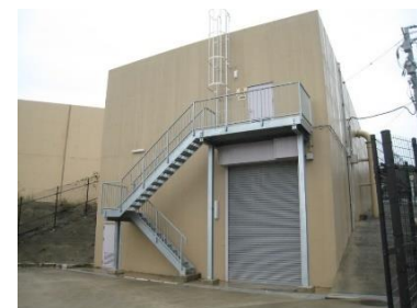
ふじと台北ポンプ所
