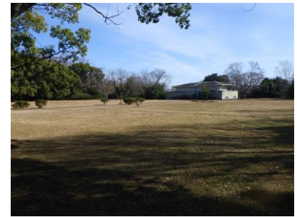
秋葉山配水池
