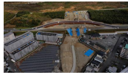
千旦樋門工事
