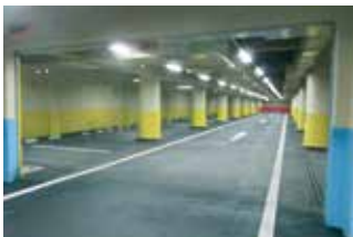
市営本町地下駐車場
