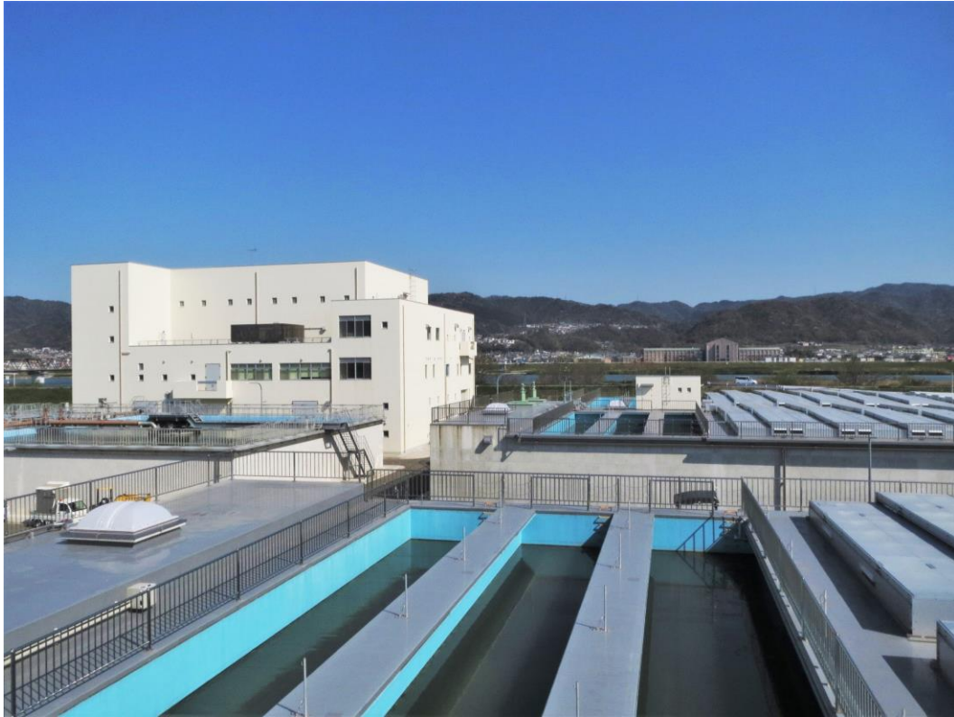
加納浄水場 凝集沈澱池
