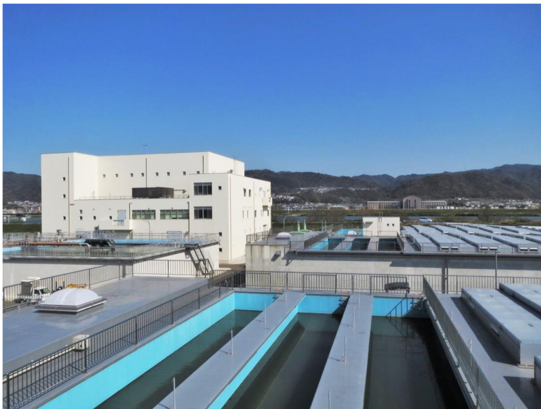
加納浄水場 凝集沈澱池
