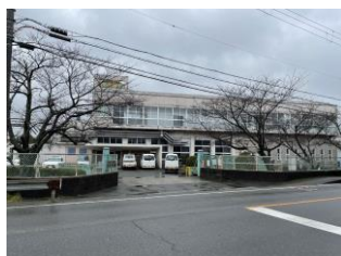
でしまじょうすいじょう 出島浄水場 和歌山市出島97
