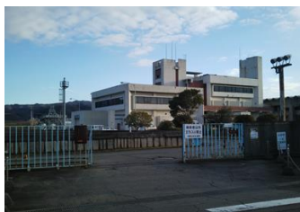
かのうじょうすいじょう 加納浄水場 和歌山市松島408の1
