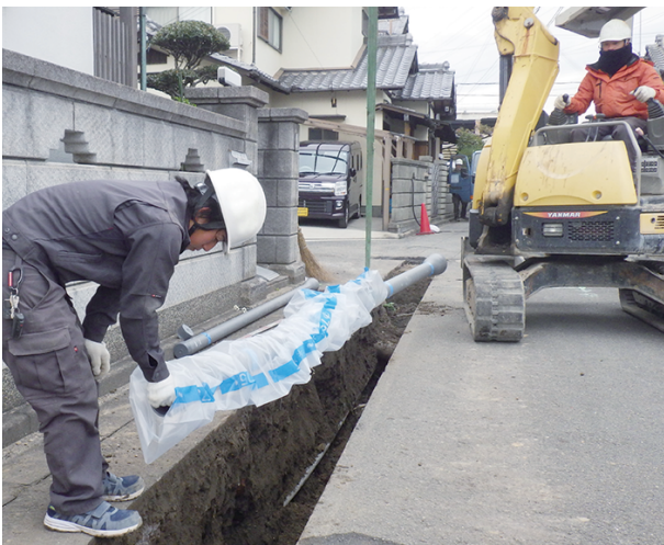
布設作業の様子
