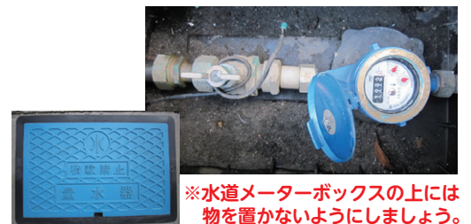
水道メーターボックス
