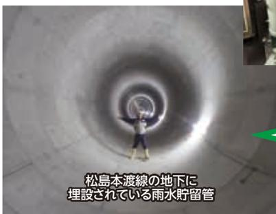
松島本渡線の地下に埋設されている雨水貯留管
