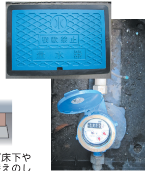
水道メーター
