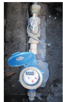
水道メーター
