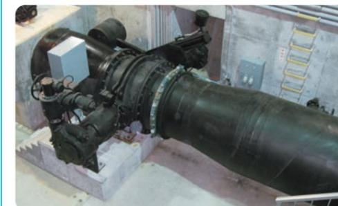
地震の揺れや、急激な水の流れをセンサーが感知すると、バルブが自動的に閉まり配水池の水が流失するのを止める装置です。
