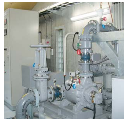
有功東中継ポンプ所
