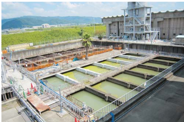
沈砂池の補強改修工事
