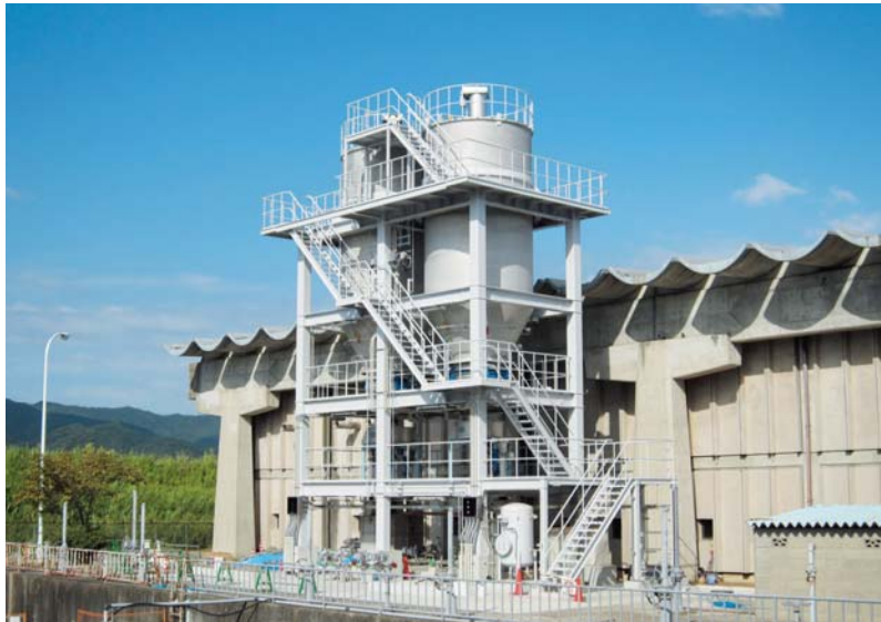
新設粉末活性炭注入設備
