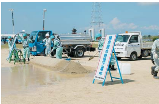
緊急漏水修理
