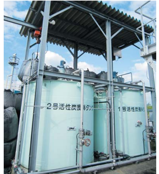
既設粉末活性炭注入設備
