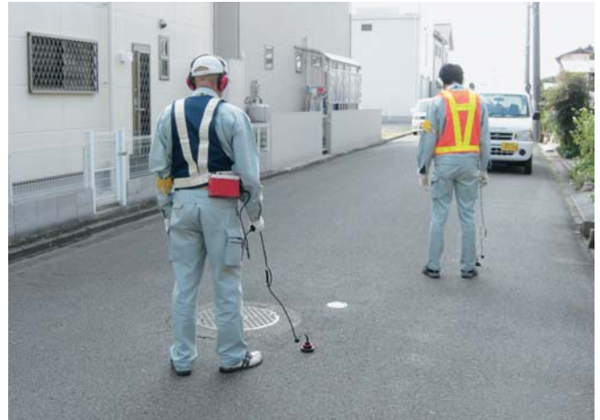
漏水探知機を使った音聴調査
