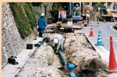
水道水をおくるために道路の下に水道管を入れる工事をします。また、古くなった水道管はこわれて水がもれる原因となるので、新しい水道管と取りかえます。
