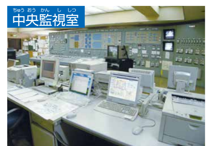
ちゅう おう かん し じつ 中央監視室 浄水場の機械の動きを調節し、異常がないか 24時間監視します。
