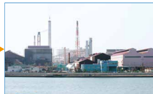
日本製鉄関西製鉄所和歌山地区
