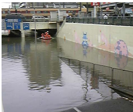
田中町南地下道（アンダーパス）の様子
