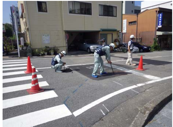
マンホール緊急点検措置状況
