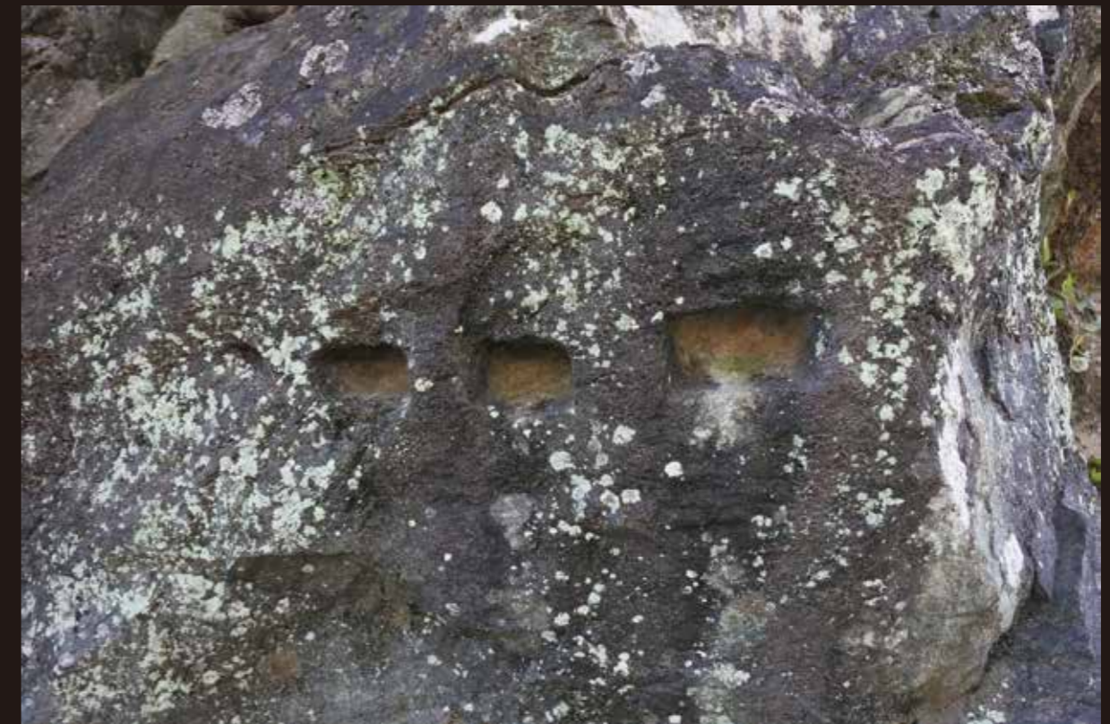
てんびざん 天妃山岩壁にみられる矢穴 Holes for quarrying out the stone on the rock cliff
