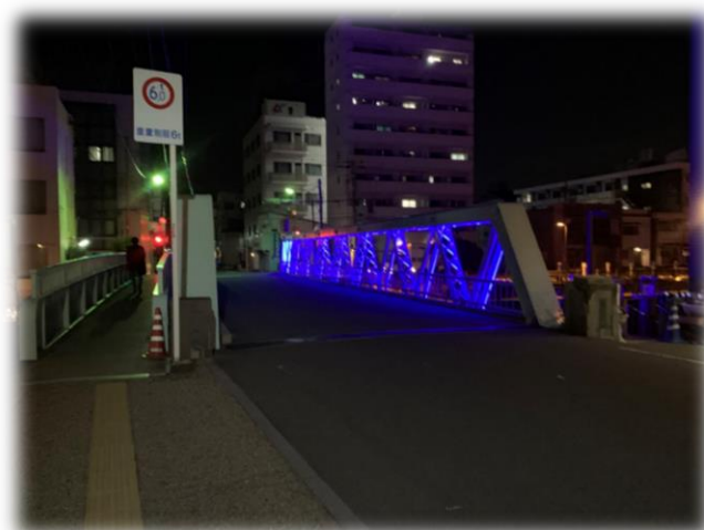
【市堀川水辺（中橋、京橋、寄合橋）】
