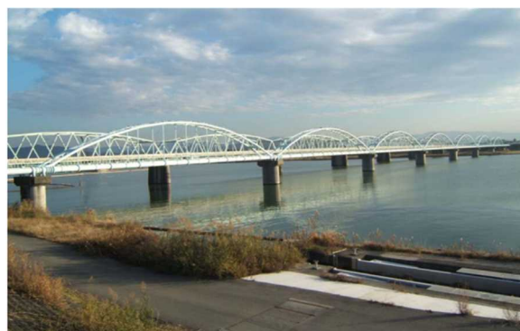
六十谷水管橋（落橋前）
