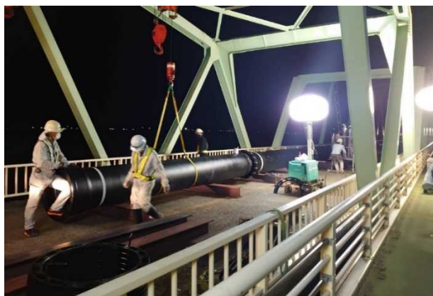
図 1.3 応急復旧工事状況
