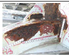
図 4.23 残存区間（P6 橋脚～P7 橋脚間）の状況
