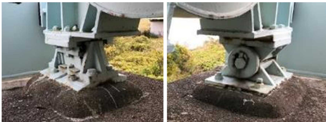
既設支承部（左：ローラー支承 右：ピン支承）
