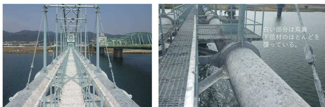
図 7.2 歩廊からみた水管橋の状況
