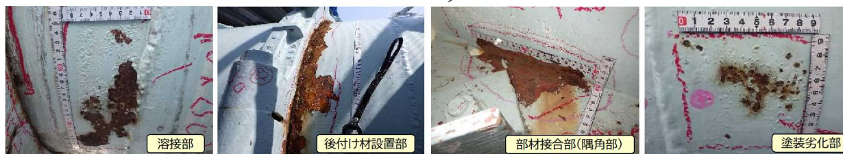
図 4.25 代表的な腐食箇所
