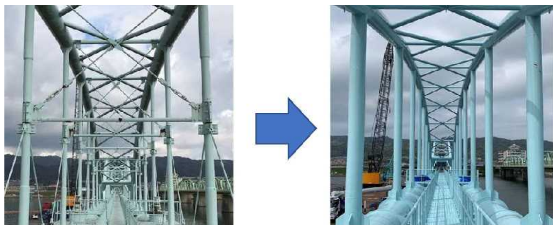
吊材をφ125（4.5t）からφ250（6.6t）に変更 ⇒ 風対策としての補強が不要となった。
