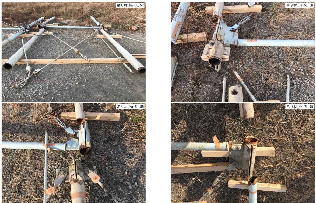
図 4.17 (2) 吊材の状況【更新区間】
