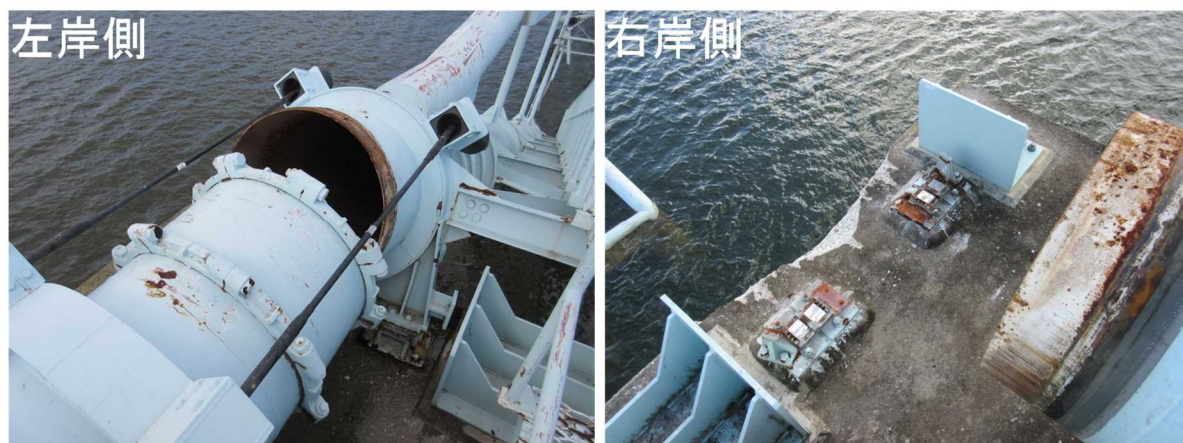
図 4.19 支承部の状況【更新区間】
