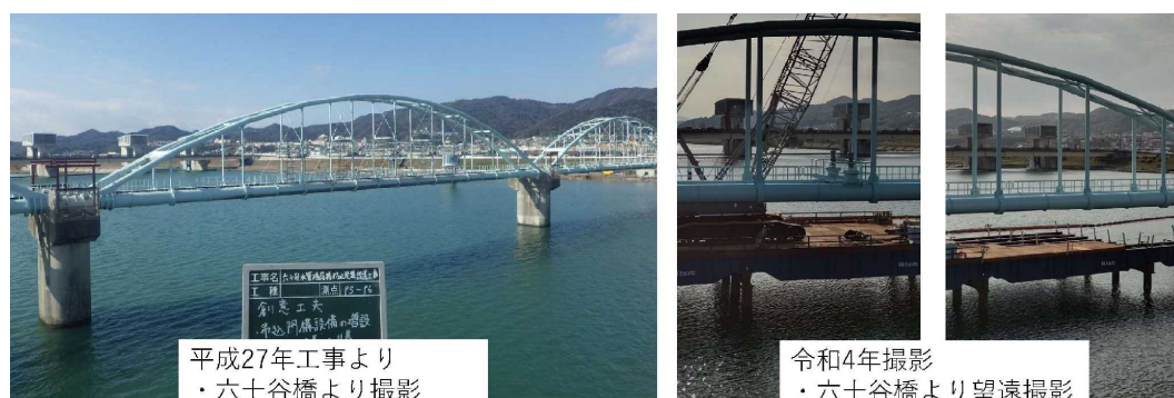
図 7.1 県道 141 号六十谷橋から望む本水管橋の確認範囲
