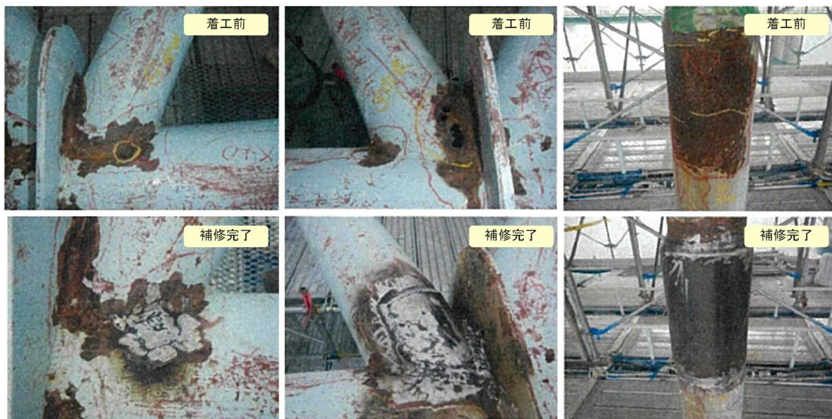
図 8.6 腐食箇所の補修状況（残存区間）
