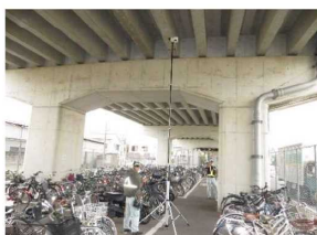
●ロボットカメラ点検
