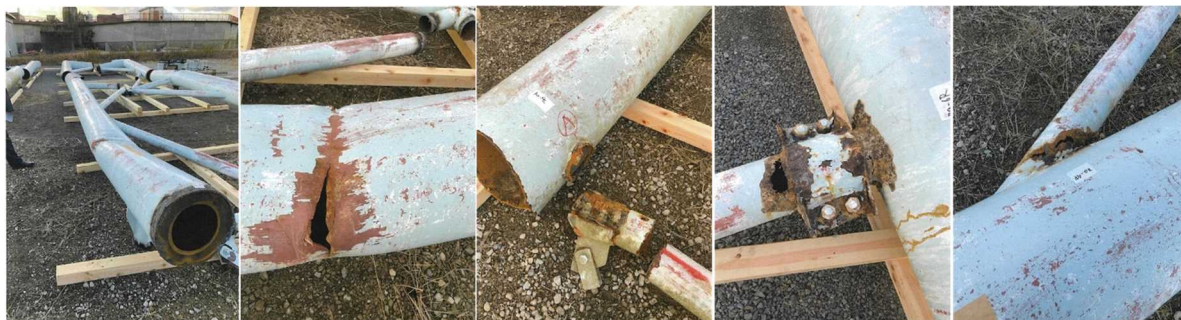
図 4.16 (2) 上弦材（アーチ材、横支材、綾材）の状況【更新区間】
