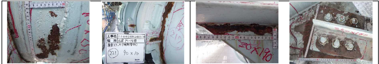
図 4.24 残存区間（P7 橋脚～P8 橋脚間）の状況
