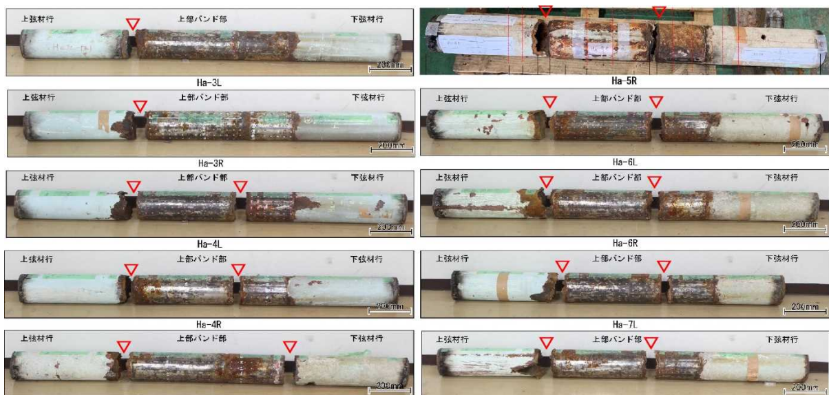
図 4.12 吊材の外観状況（分析試料採取前）
