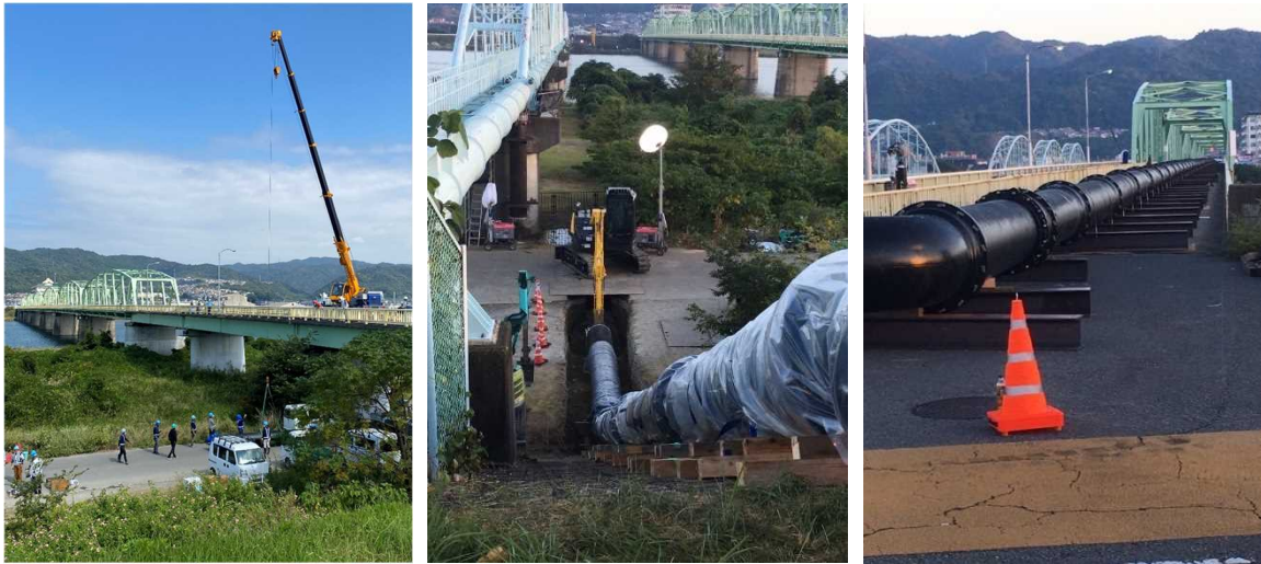
図 1.5 応急復旧工事状況
