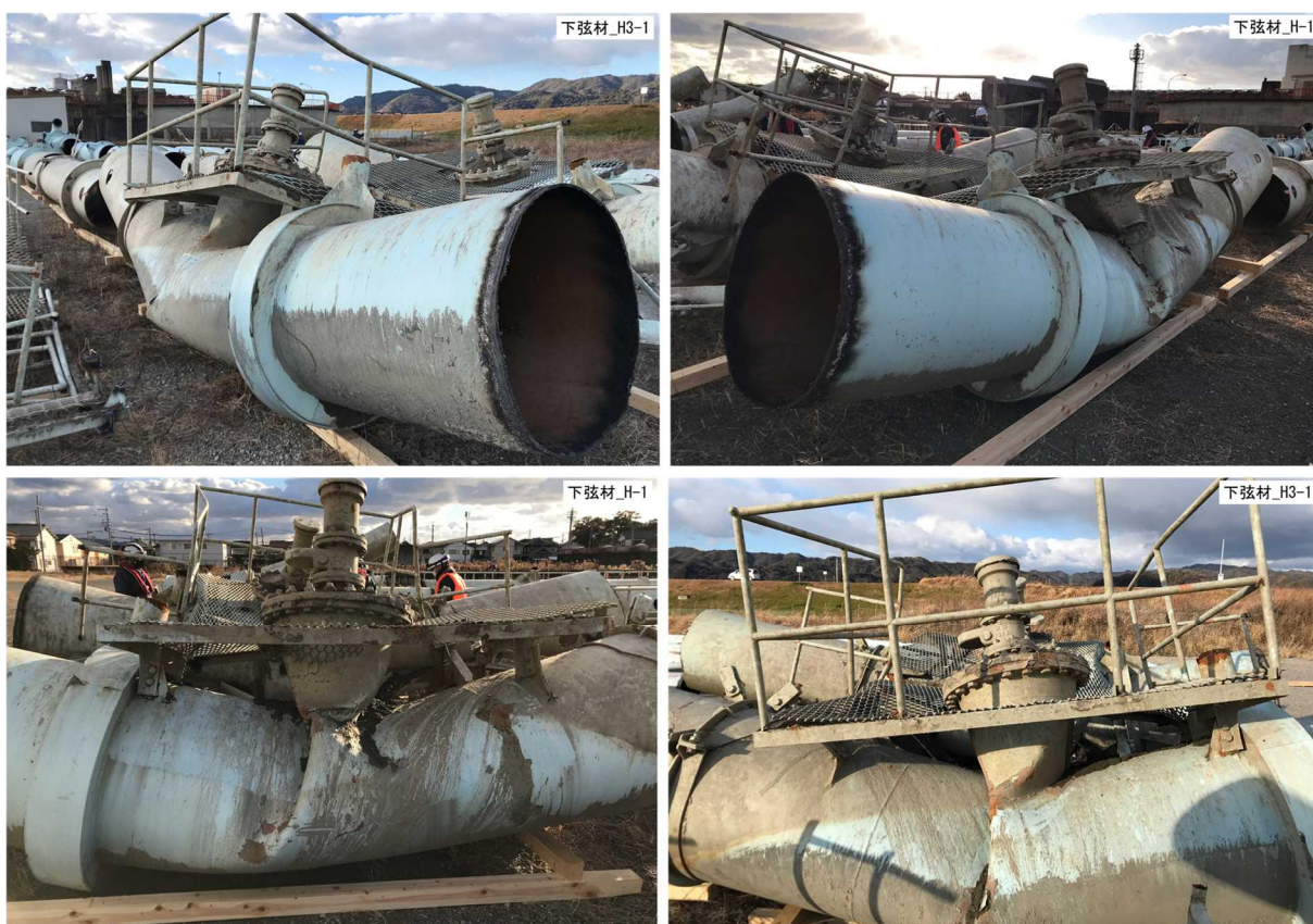
図 4.18 (2) 下弦材（通水管、横支材、綾材）の状況【更新区間】
