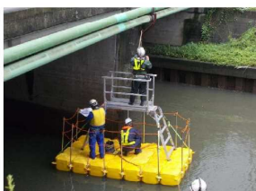
●浮き桟橋点検
