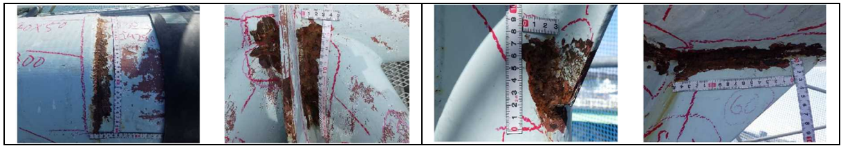
■下弦材（通水管：外面）
