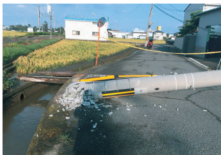
停電の原因となった電柱の倒壊
