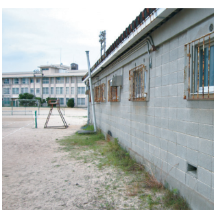
ブロック造建築物
