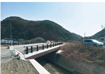
坂田磯の浦線の進捗状況
