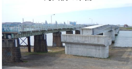
河西橋の架替
