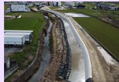
永山川護岸改修の様子
