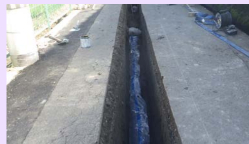
管路の更新状況
