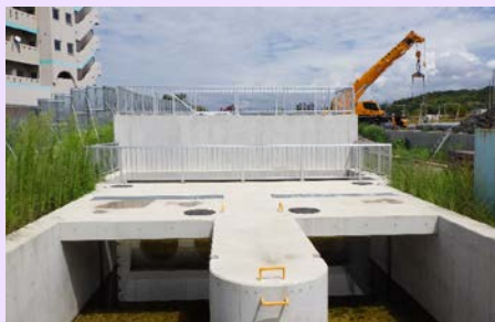
建設中の中島川雨水ポンプ場
