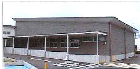
和歌山市民図書館西分館
