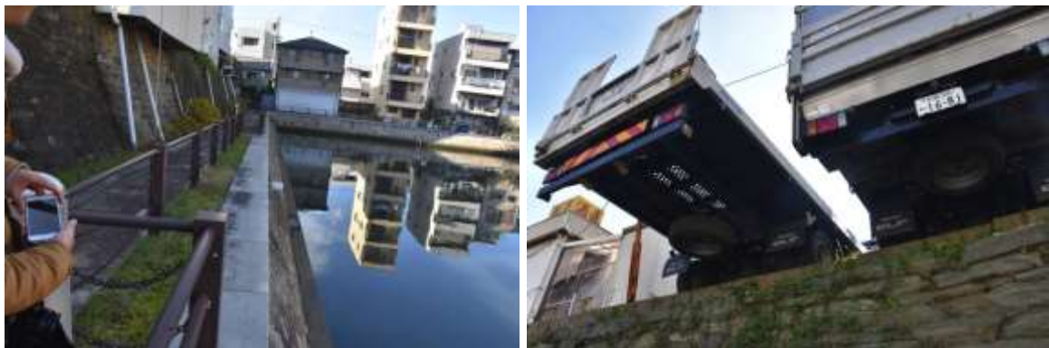
図表 1-2-12 現在に残る市堀川左岸の土塁地形
