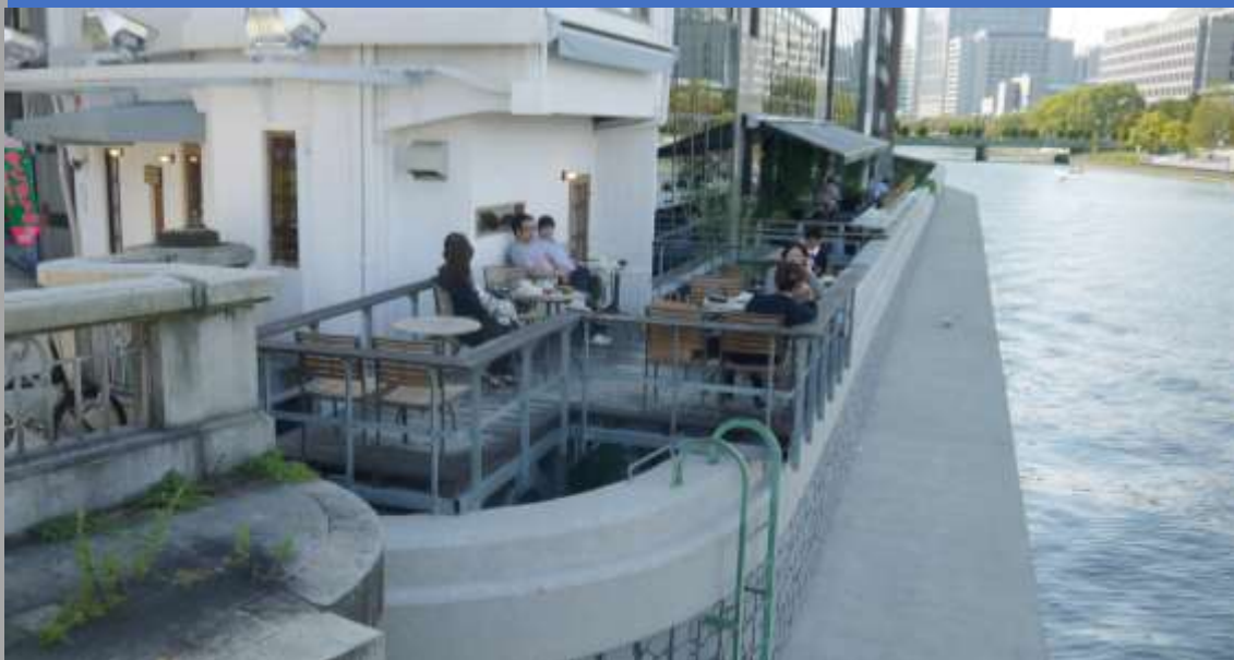
写真1：河川占用の特例措置に基づき管理用通路上に縁台型テラスを設置し営業
