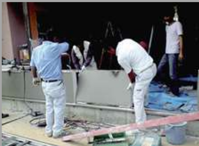
写真 3：川沿いビルのリノベーションの様子
