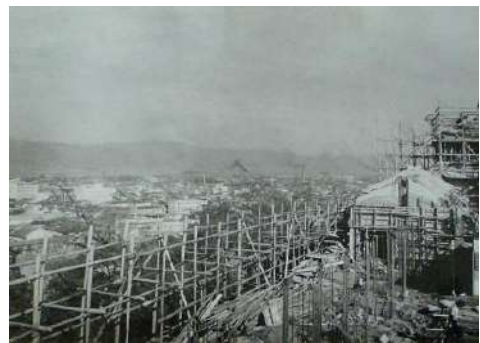
天守閣再建工事 (昭和31年（1956）～昭和32年（1957）頃)
