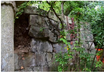
石積崩落部 東端よりおよそ3m位置
