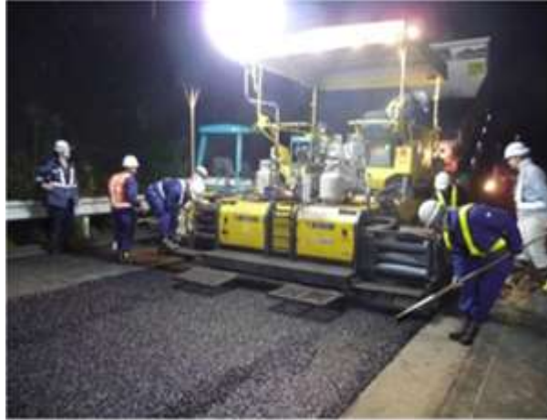
《施工状況(イメージ)》
