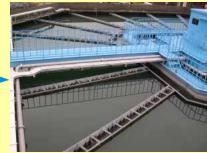
硫酸バンドを入れ撹拌し,濁り物質 を凝集沈澱させ,うわ水を集水しま す。
