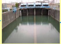
水の流れを遅くして,水中の約0.1mm以上の砂を沈めます。
