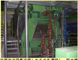
沈澱池で凝集沈澱したものを濃縮し,脱水機 で水分を絞り,乾燥させます。
