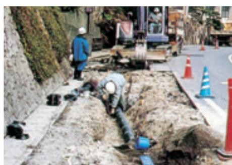
古くなった配水管を計画的に耐震性のすぐれた配水管に取り替え、給水サービスの向上を図っています。
