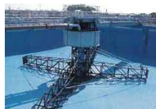
完成した濃縮槽内部
