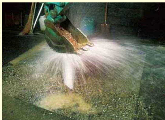
水道管の老朽化などが原因で発生した漏水の修理途中の写真 水圧により持ち上がった舗装箇所を切り取り撤去し、漏水管修理のため道路路盤の掘削にとりかかるところ。
