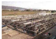
建設中の脱水機
