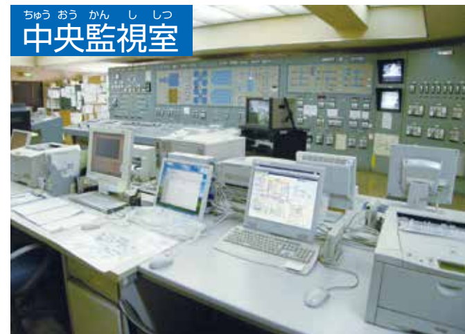
浄水場の機械の動きを調節し、異常がないか24時間監視します。
