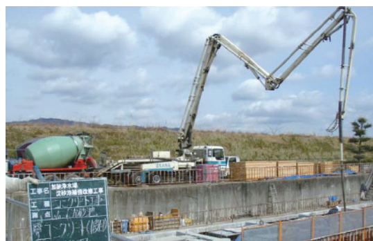
加納浄水場の耐震化
