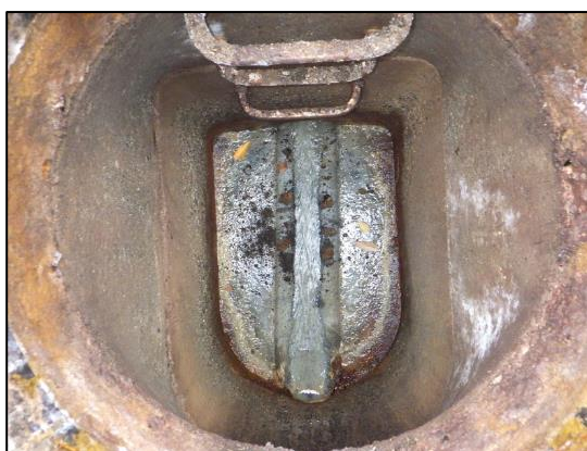
マンホール内の状況
