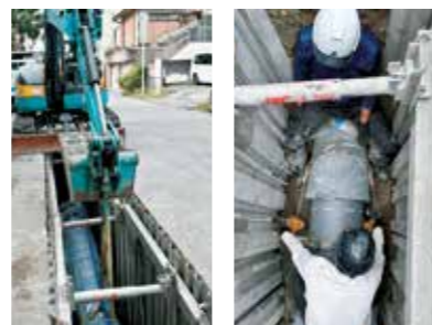
↑令和6年度に比べ更新する配水管を約35%延長拡大
