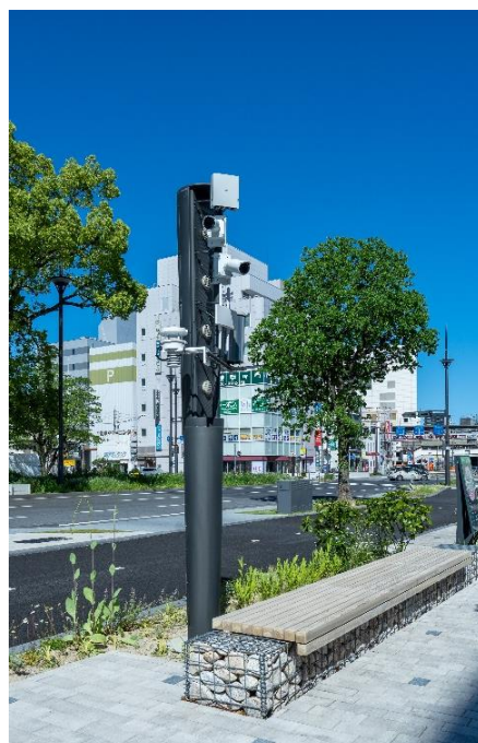
スマートポールの導入事例 (四日市市)
