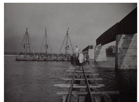
河西橋の架橋工事の古写真
