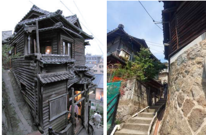
狭い路地や高低差のある立地でありながら、空き地・空き家等を活用した民間主導のまちづくりを進めている。
