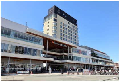
駅直結の複合施設「キーノ和歌山」
