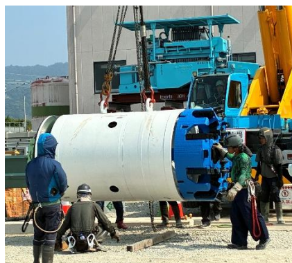
【シールドマシン搬入状況①】
