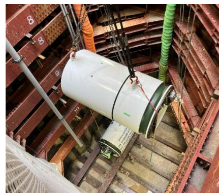
【シールドマシン搬入状況③】
