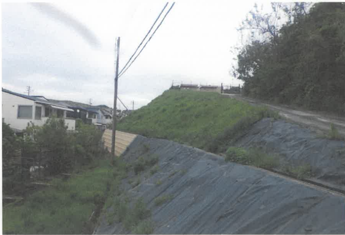
ふじと台南 低区配水池 北側 斜面及び平地
