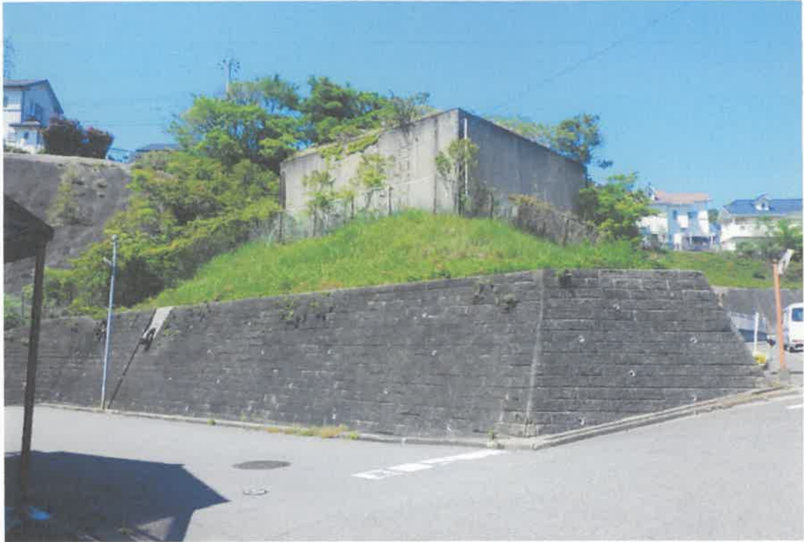
旧有功東 配水池 南側 斜面
