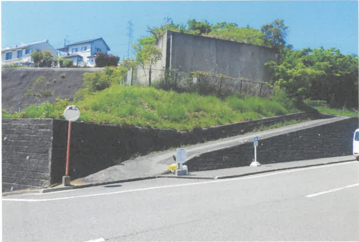
旧有功東 配水池 南側 斜面
