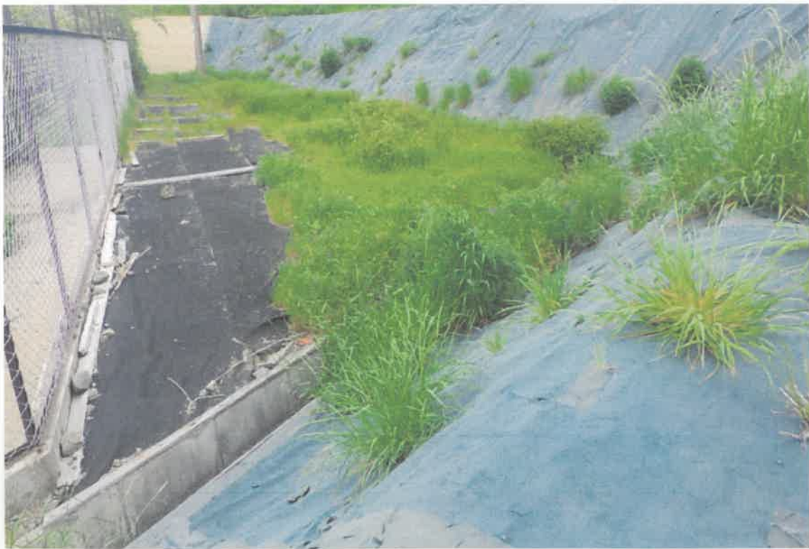
ふじと台南 低区配水池 北側 平地 【撮影日】 令和8年4月 22日
