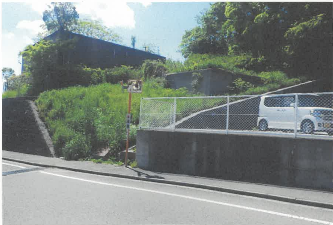
旧有功東 配水池 東側 斜面
