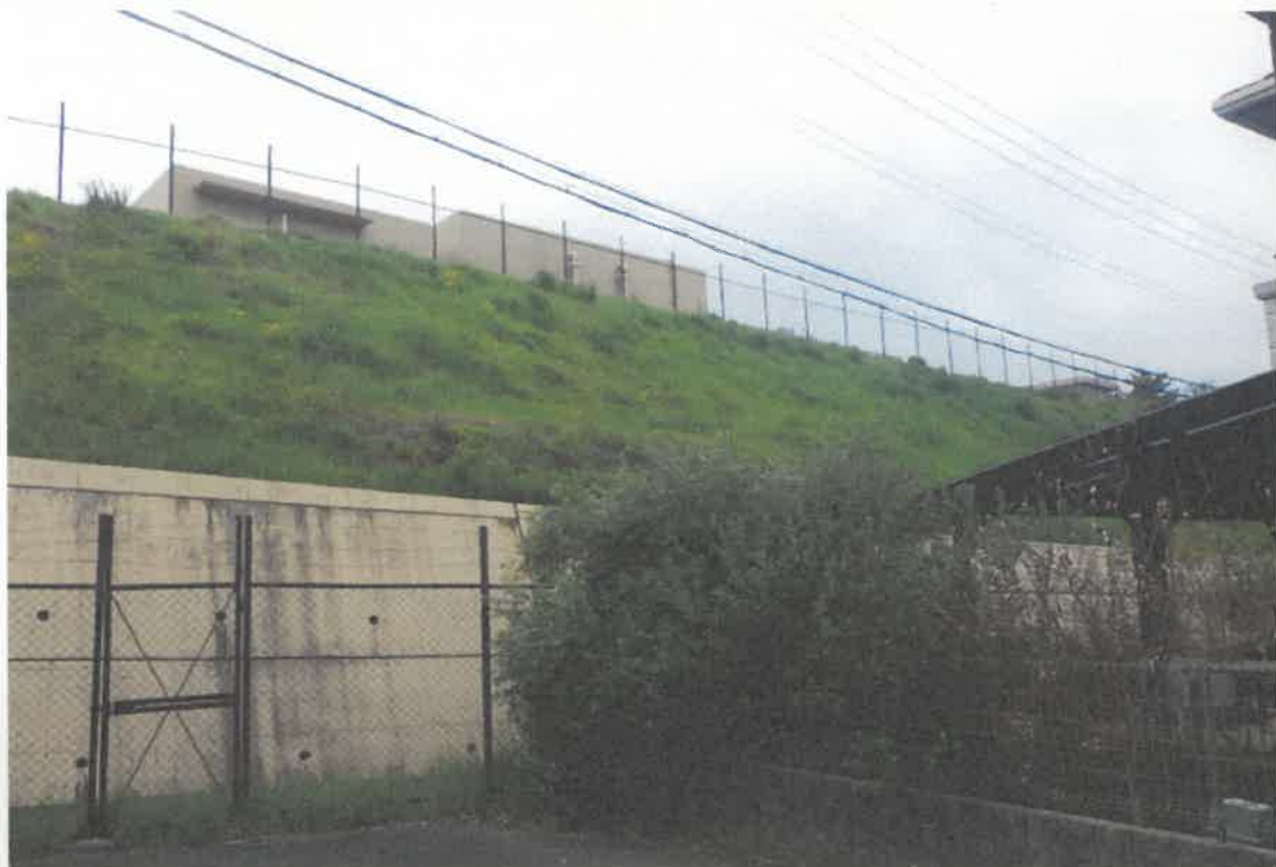
ふじと台南 低区配水池 北側 斜面
