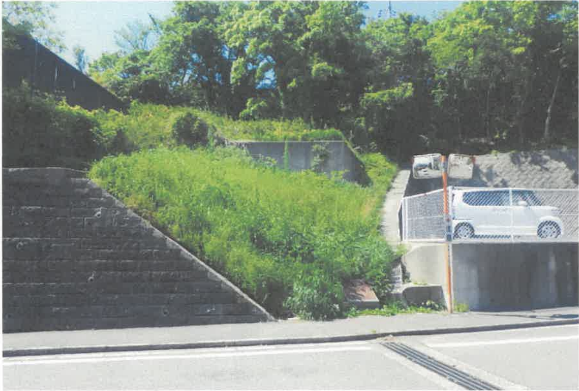
旧有功東 配水池 東側 斜面
