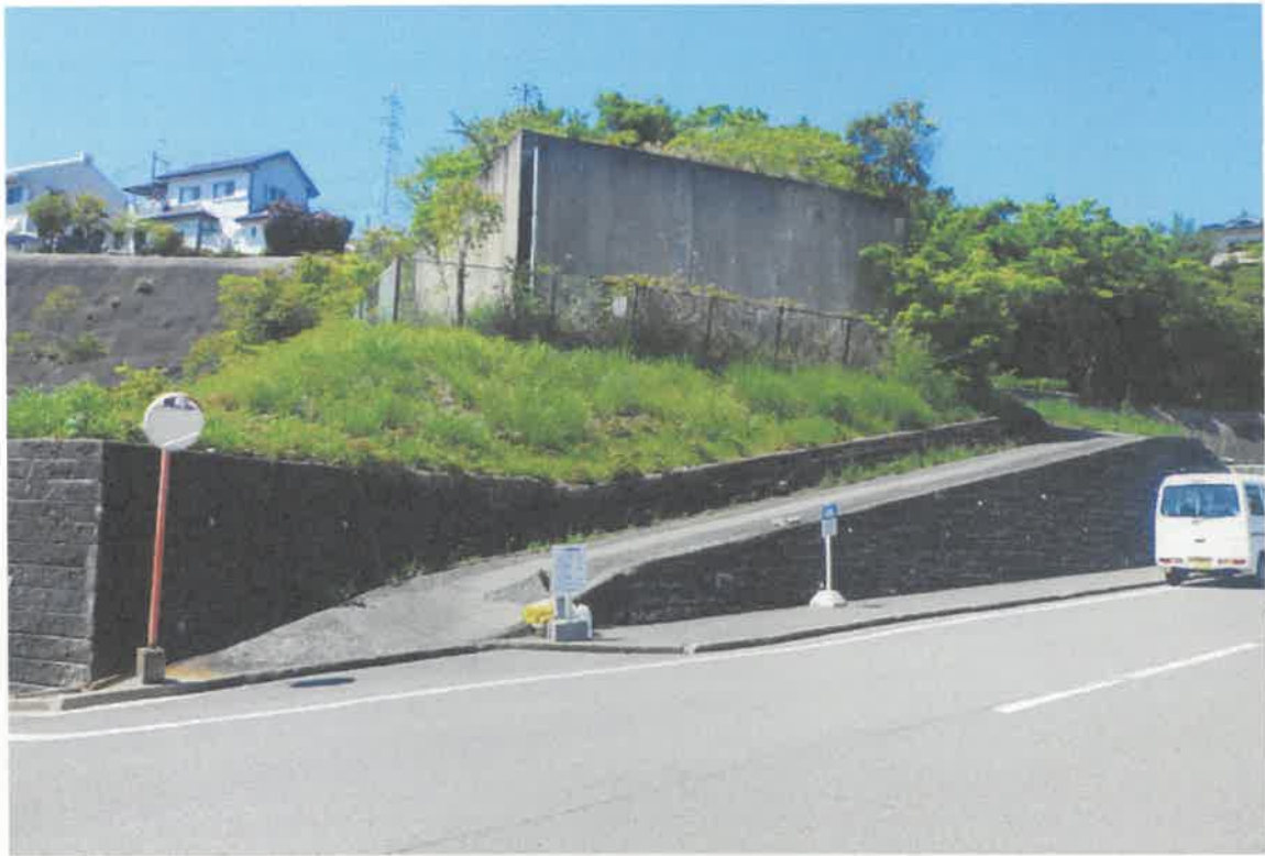
旧有功東 配水池 南側 斜面
