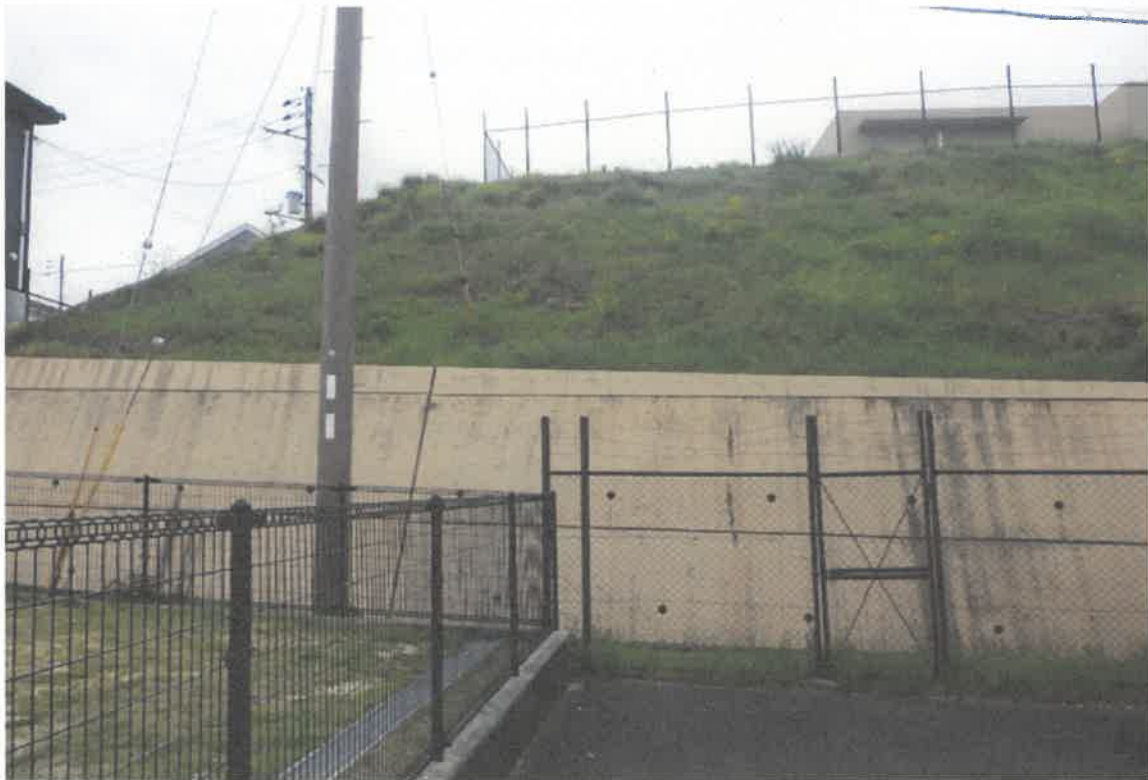
ふじと台南 低区配水池 北側 斜面
