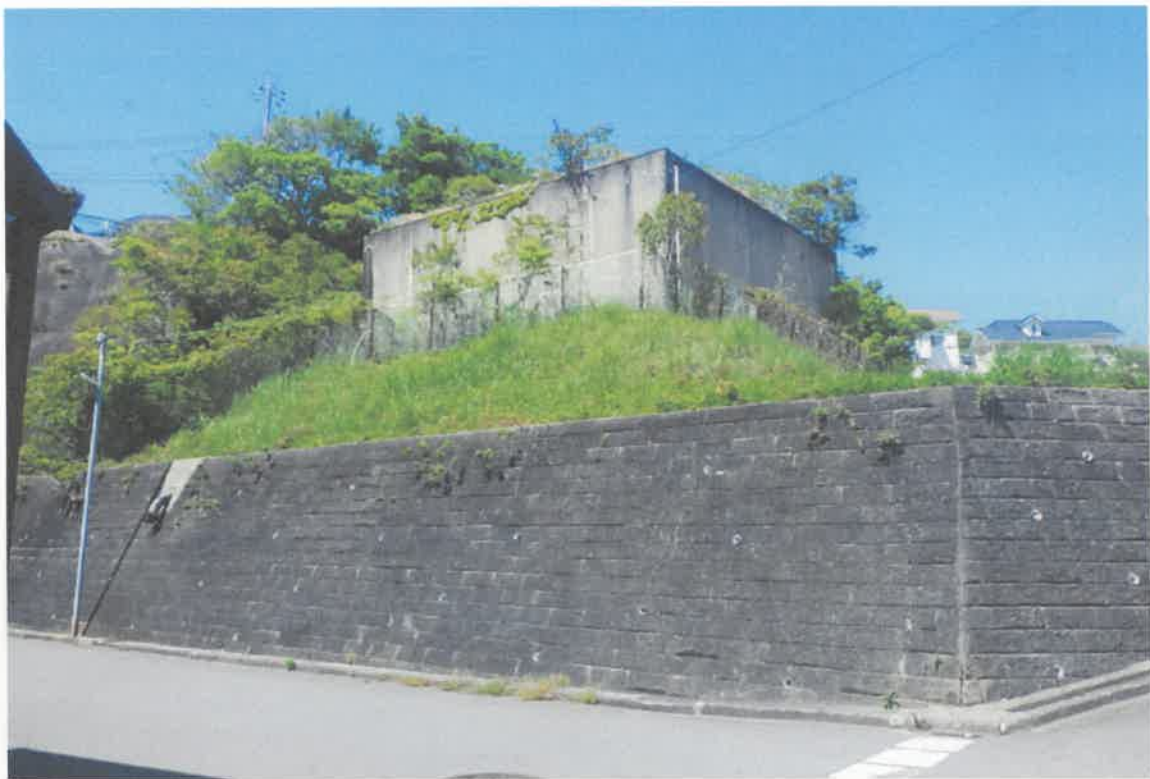
旧有功東 配水池 南側 斜面
