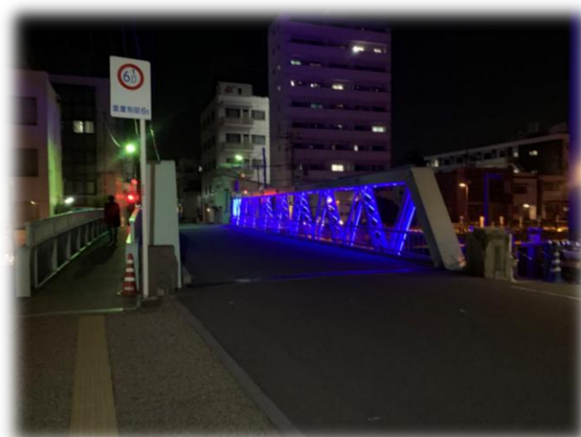
【市堀川水辺（中橋、京橋、寄合橋）】
