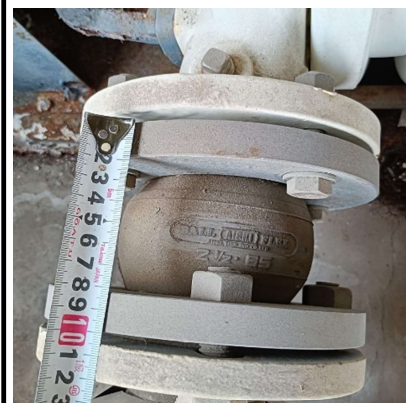
防振継手 (吸込側)
