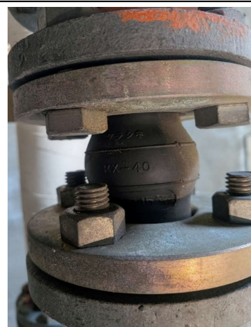
防振継手 (吸込側)
