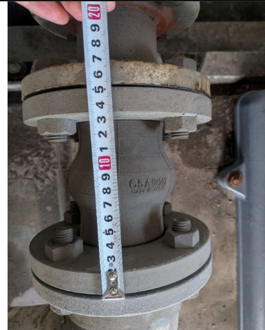
防振継手 (吸込側)
